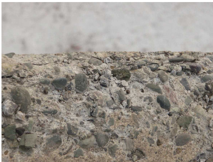
スケーリング事例 （塩害+凍結融解作用）
