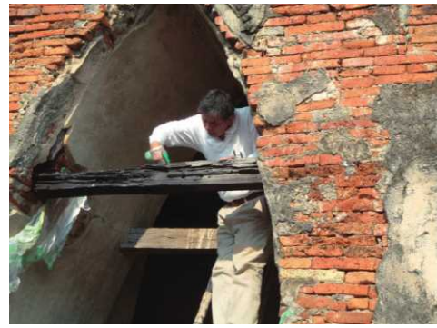
写真-18 木材への高含浸性強化剤の吹付け
