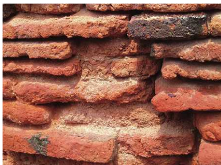
写真-7 溶解したように見える煉瓦 (手で触れると砂状になる)
