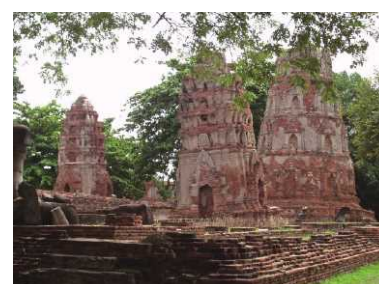
写真-3 傾いた仏塔
