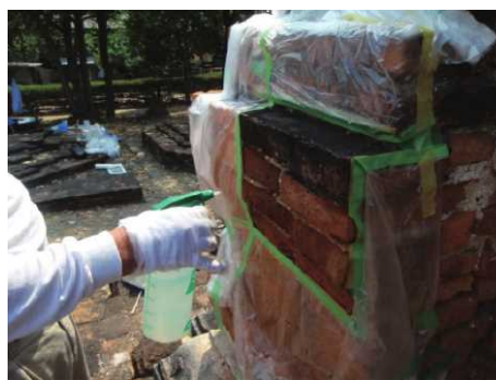
写真-14 高含浸性強化剤の吹付け
