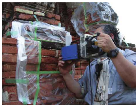
写真-13 ドリル削孔試験
