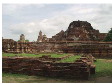
写真-1 ワット・プラ・マハタートの様子(一部)
