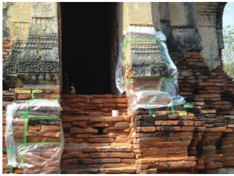
写真-16 補修工事における養生
