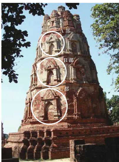
写真-8 高さ方向で異なる劣化状況
