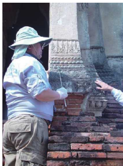
写真-15 浮きの打音調査
