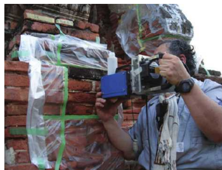
写真-13 ドリル削孔試験
