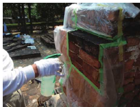
写真-14 高含浸性強化剤の吹付け
