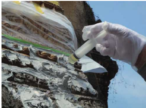
写真-17 樹脂注入工程
