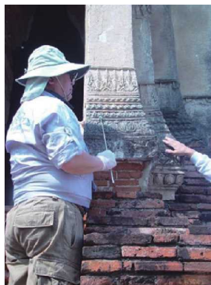
写真-15 浮きの打音調査
