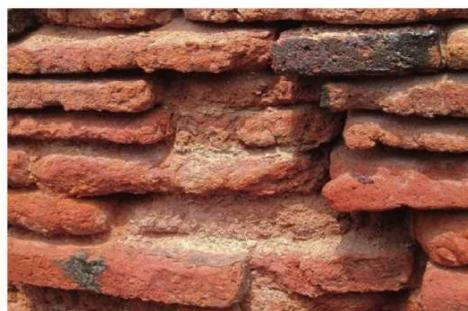
写真-7 溶解したように見える煉瓦
