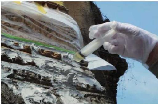
写真-17 樹脂注入工程
