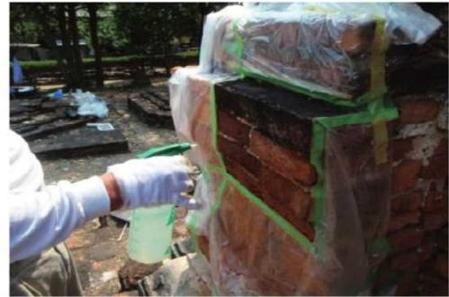
写真-14 高含浸性強化剤の吹付け
