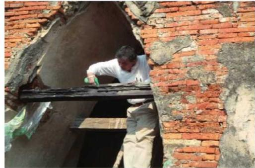
写真-18 木材への高含浸性強化剤の吹付け
