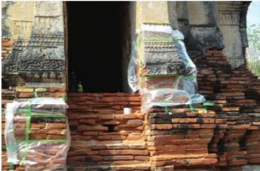
写真-16 補修工事における養生
